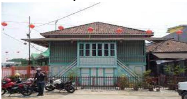
Gambar 4. Tampak depan rumah panggung Cina yang ada di 10 Ulu (sumber: data pribadi Rifita Indasari, 2021)
